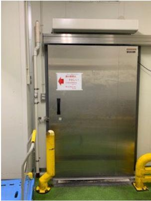
マグロ切断作業場のすぐ隣には、マイナス 60 度の冷凍庫がある。船上で冷凍処理されたマグロは、日本に運ばれてからも直ちに超低温冷凍庫に移され、保管され続けるのだ。切断のために取り出したマグロも、また直ぐにマイナス 60 度へ戻される。釣り上げた直後から、加工、販売されるまで、このように一貫して超低温保管し続けることで、マグロの鮮度が保たれている。
