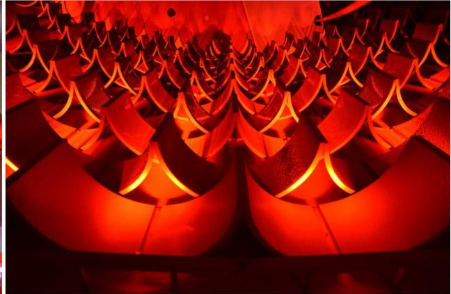
塔内の吹き抜け空間の内側には、赤色の拡散板が並ぶ。拡散板は、その突起部分が交互に続くように大きさや配置を調整し取り付けを行った(写真:菅原 由依子)
