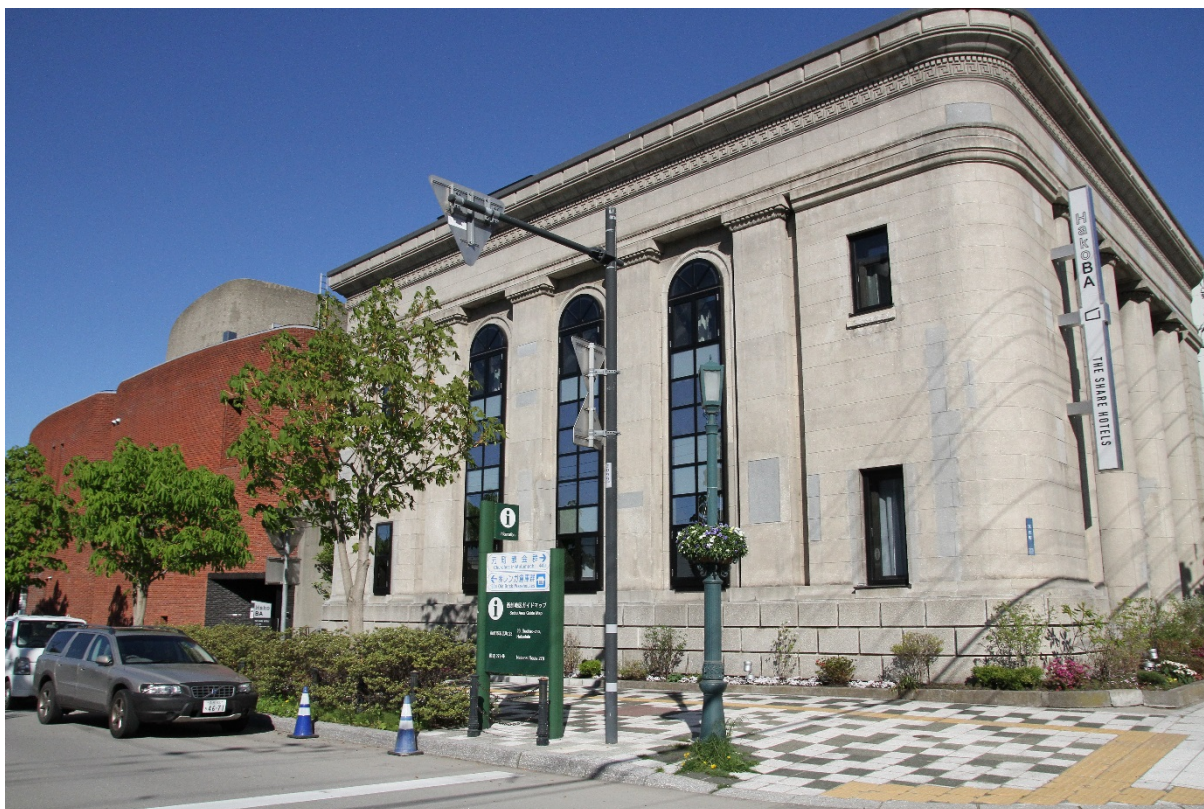
築 85 年の BANK 棟。元銀行の意匠を楽しめる。左に見える建物は DOCK 棟(写真提供:リビタ)
