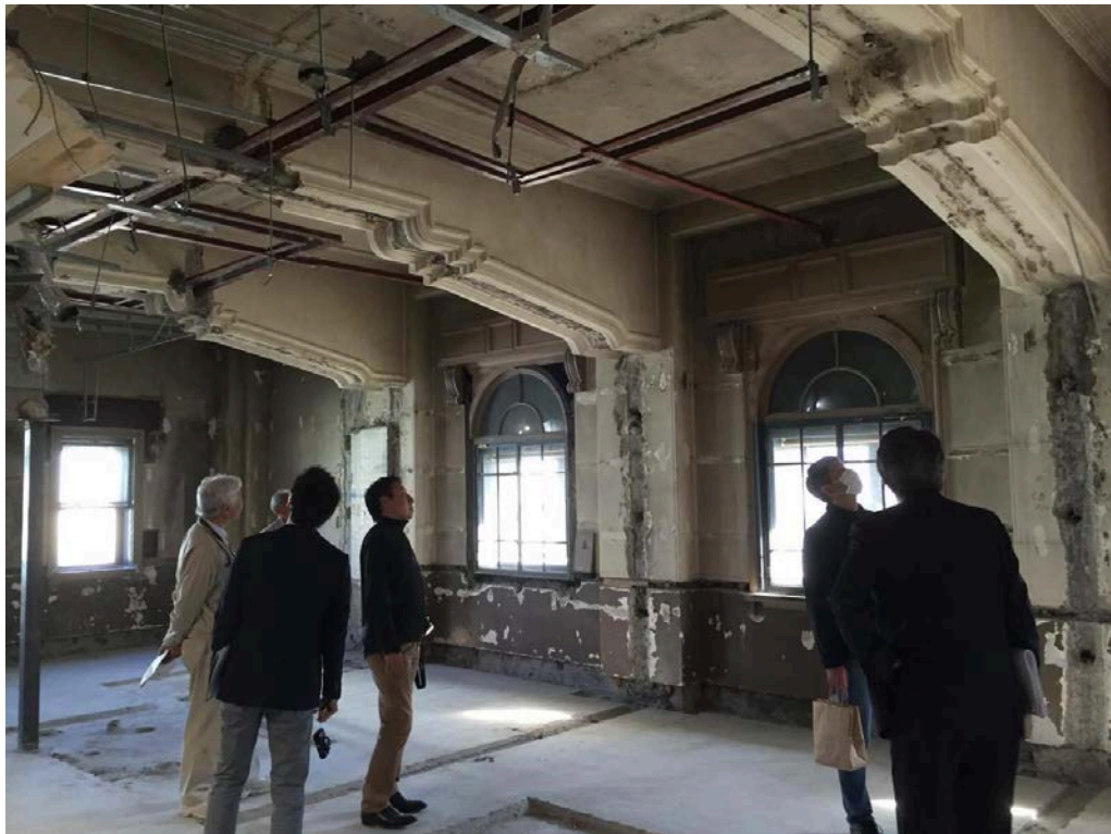
BANK 棟の工事中的様子。天井の上に巨大な梁や木製の窓枠などが現れた(写真提供:リビタ)
