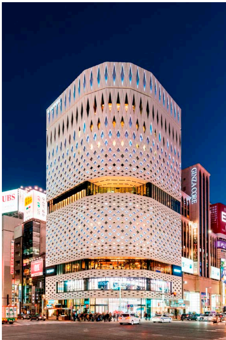
GINZA PLACE の夜景。透かし彫りをイメージした外壁が美しくきらめく。開口部ごとに明るさと色をプログラム制御するフルカラーLED 410 個を導入している。季節に合わせて照明の演出を変えている(写真提供: サッポロ不動産開発)
