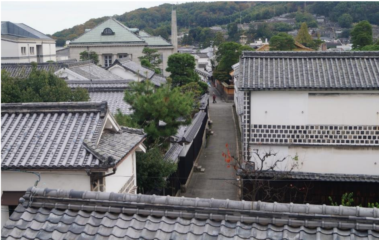
「林源十郎商店」屋上からの眺め。手前の家屋には棧瓦が葺かれている。
