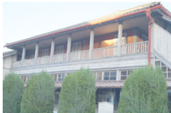
フランス人女性教師の住居として建築された女工館
